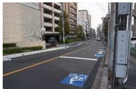
矢羽根の整備事例 (E170号線(坂下通り))
