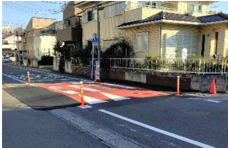
仮設スムーズ横断歩道による実証実験 (生活道路対策エリア 「さいたま市大宮区三橋二・四丁目地区」)
