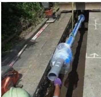
老朽管更新工事
