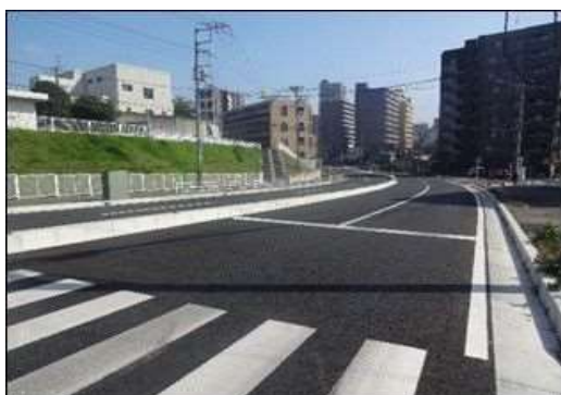
田島大牧線（2工区） 新設整備
