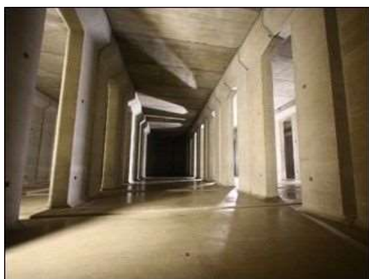
公園の地下を活用した雨水調整池の整備
