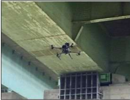
ドローンによる橋りょう点検
