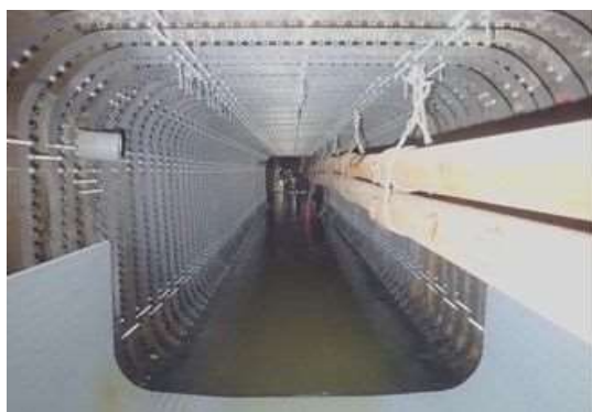
老朽化した下水道管の更生
