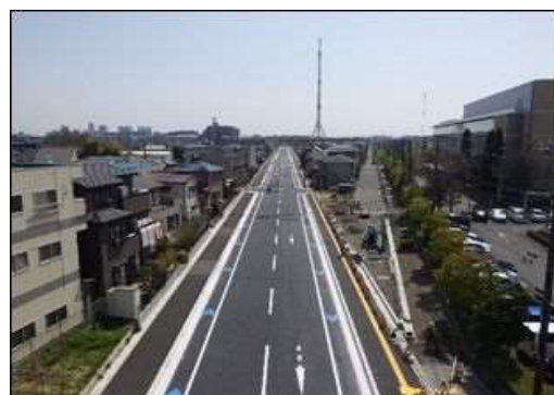
大谷場高木線（道場工区） 新設整備
