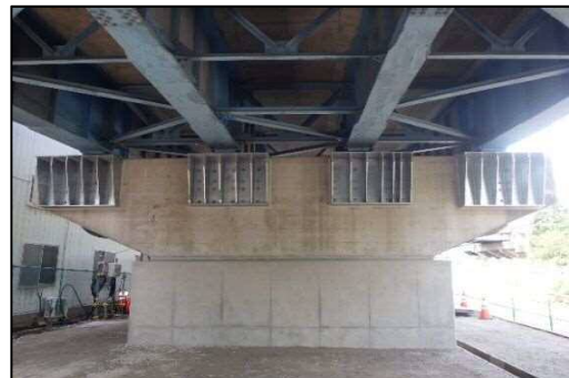
落橋防止装置の取付、橋脚の補強
