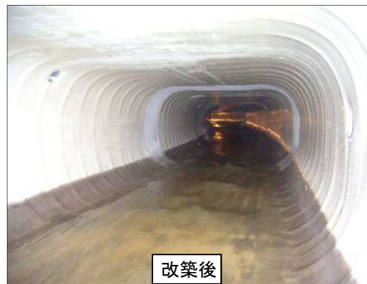
老朽化対策（管きよ更生工法）[大門浅間2号幹線]
