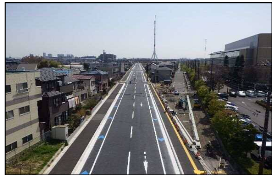
大谷場高木線（道場工区） 新設整備
