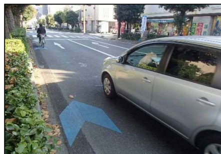
矢羽根の整備事例(市役所通り)
