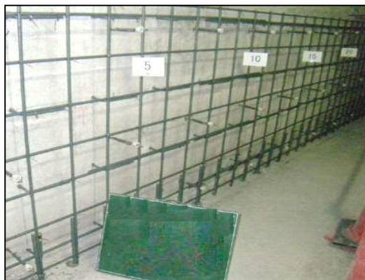
ポンプ場の耐震化（壁の補強状況）
