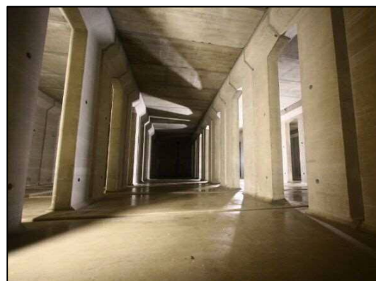
浸水対策 プレキャスト地下式調整池[日進調整池]
