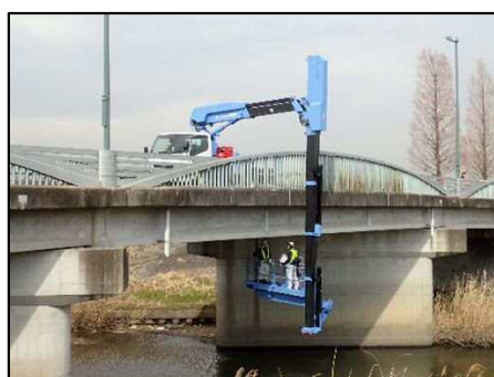
橋りょう点検車による点検
