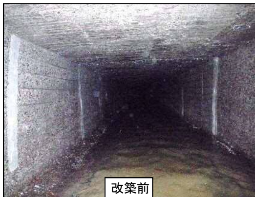
老朽化対策（管きよ更生工法）[大門浅間2号幹線]
