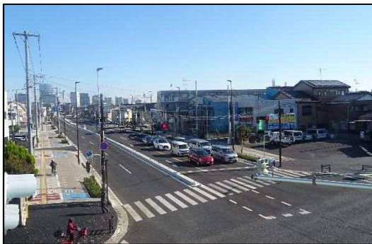
三橋中央通線（三橋工区） 拡幅整備
