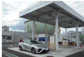
浦和水素ステーション （都市ガスによる水素製造・天然ガススタンド併設）
