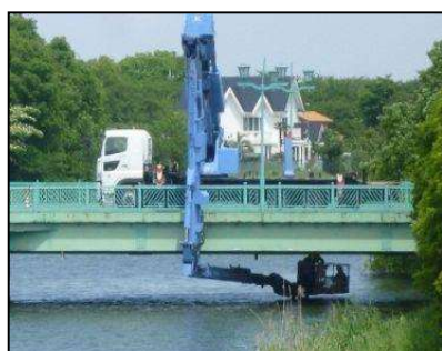
橋りょう点検車による点検
