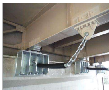
落橋防止装置の取付
