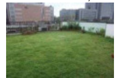
(屋上緑化施工例)
