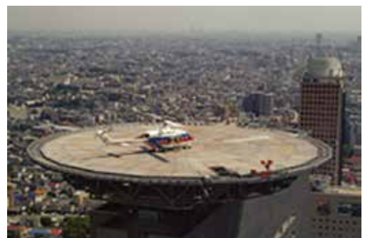
▲ヘリポート（さいたま新都心合同庁舎2号館） 出典：国土交通省関東地方整備局ホームページ
