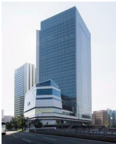
▲独立して視認できる議会棟 (横浜市役所)
