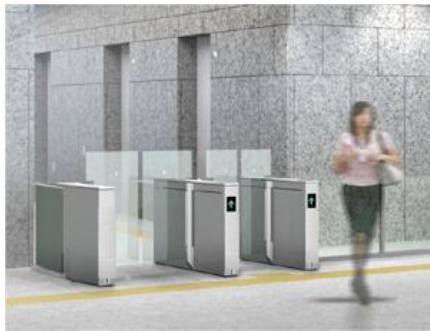
▲ I Cカードとゲートによるセキュリティシステム (東京都庁)
