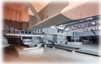
参考事例 地下免振装置 (越谷市役所) 出典：越谷市ホームページ
