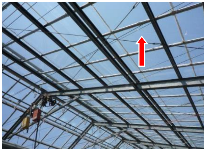
屋根材の補強：X字状に設置
