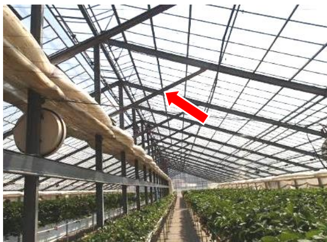
屋根と柱の補強（角パイプ）
