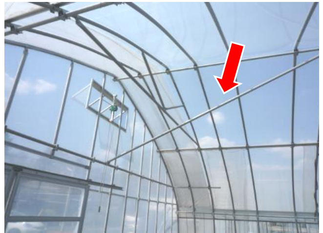
妻面と屋根の補強
