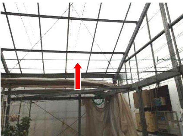
妻面に設置（ワイヤー）
