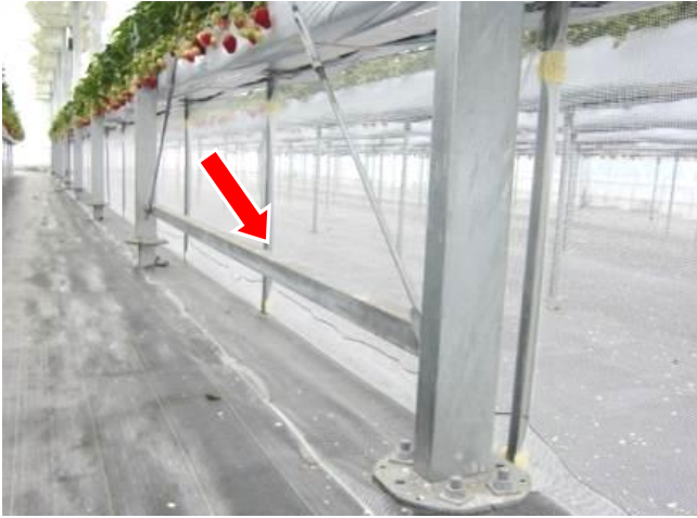
柱と柱の補強（角パイプ）
