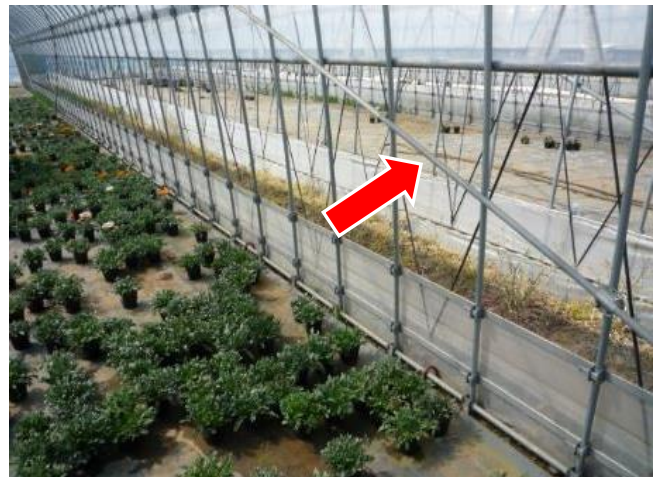
サイド部の補強（筋交い）
