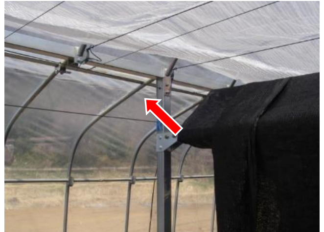
柱と梁を補強
