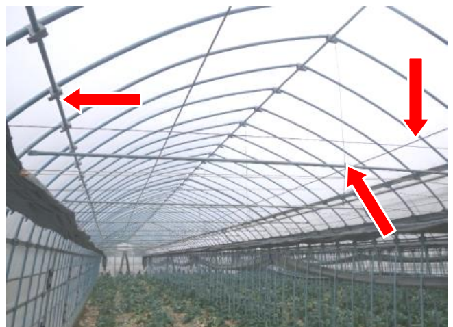
タイバーと屋根と妻面の補強
