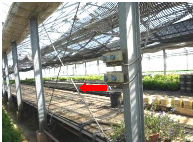
柱材の補強：X状に設置
