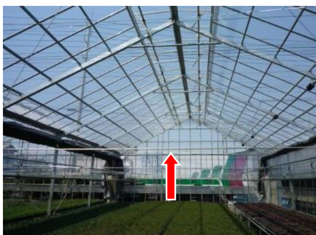
柱材の補強：梁状に設置
