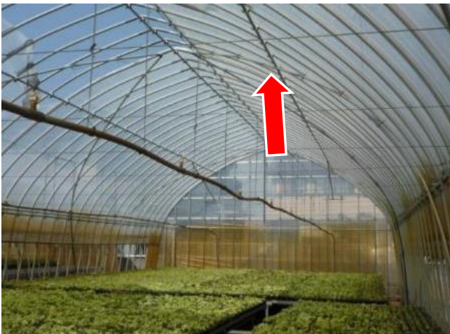
屋根の補強（母屋パイプ）
