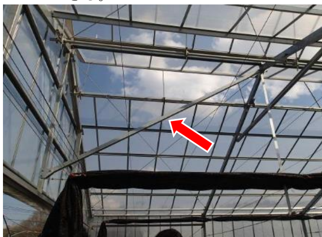
妻面と屋根の補強（角パイプ）
