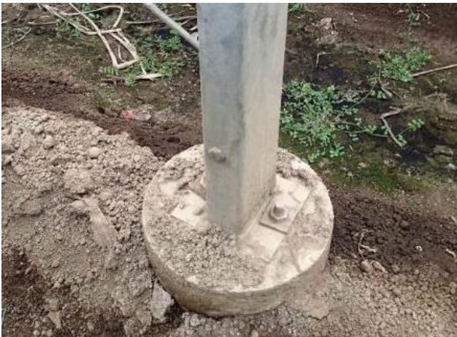
セメントの容積・接地面が大きい
