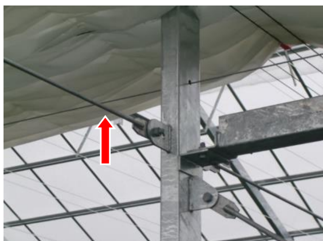
柱材の補強：梁状に設置
