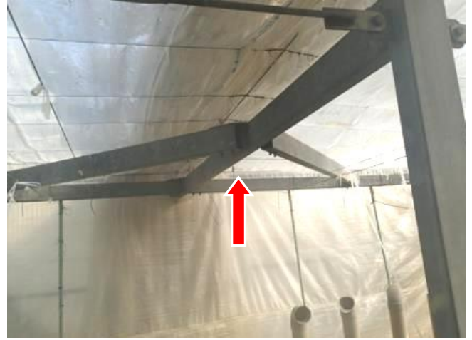
梁と柱の補強（角パイプ）
