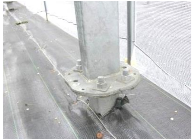
鉄柱基礎（鉄柱打ち込み：約1 m）
