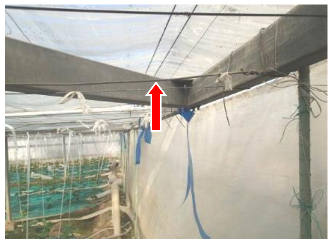
梁材に設置（ワイヤー）
