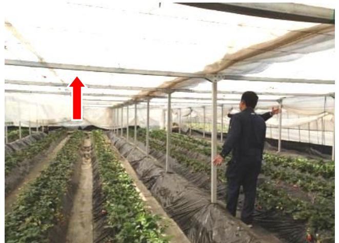
柱材の補強：角パイプ鋼材陸梁
