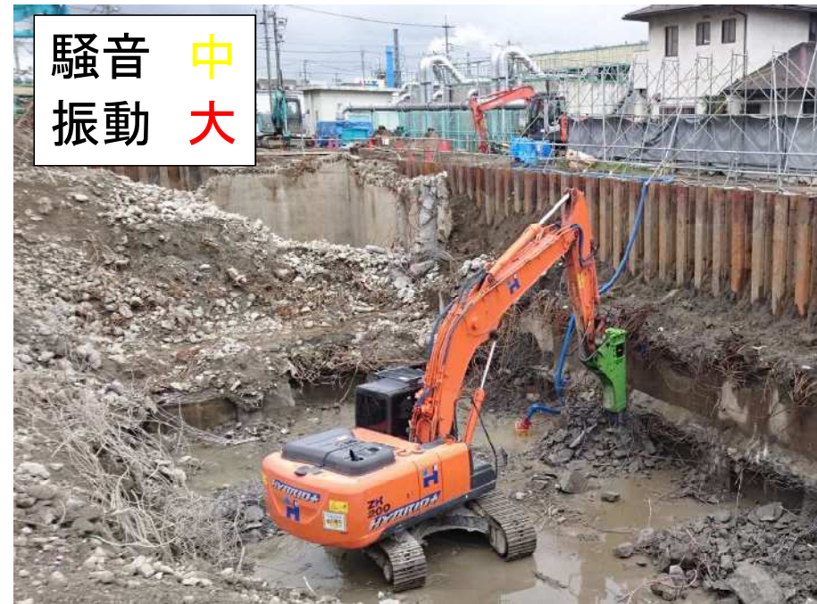
地下部・基礎解体工事施工状況 参考写真
