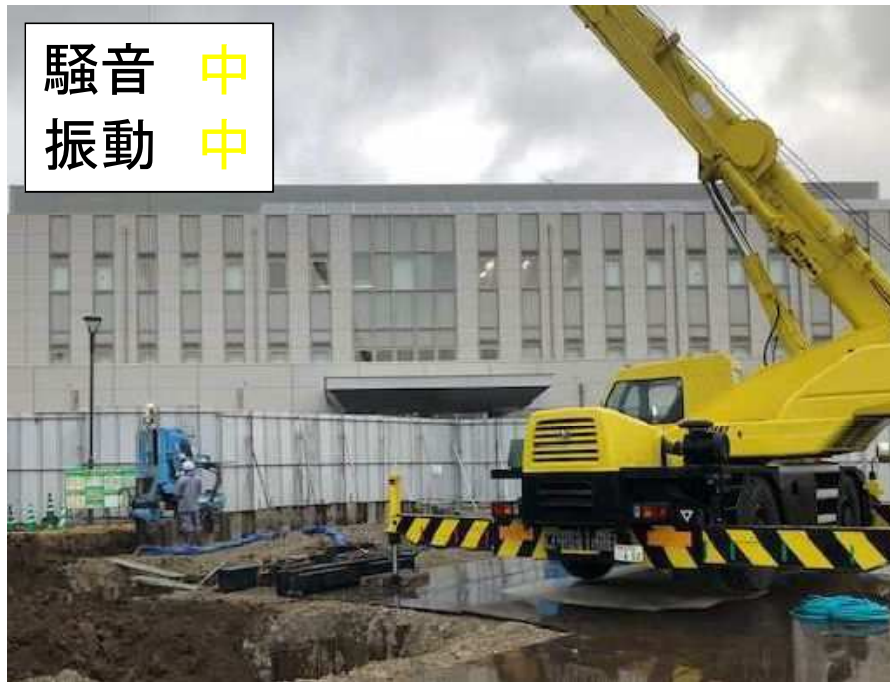
山留め工事施工状況 参考写真
