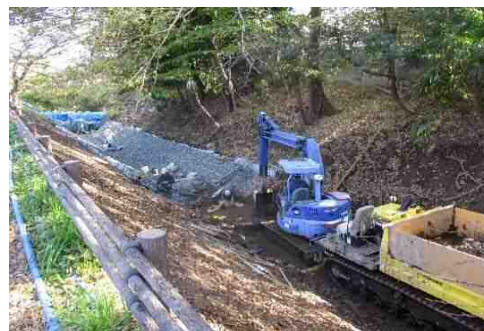
国指定史跡見沼通船堀西縁工事の様子
