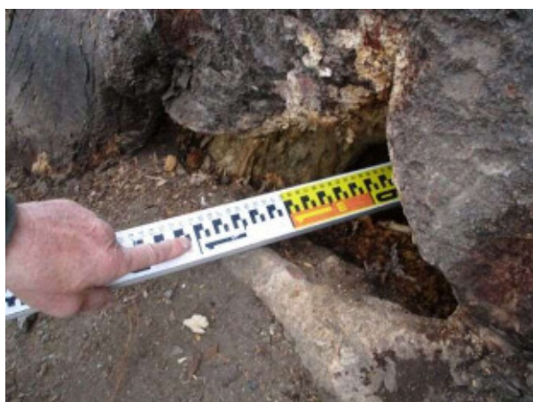
▲根元には大きな空洞が生じていた（平成31年2月撮影）
