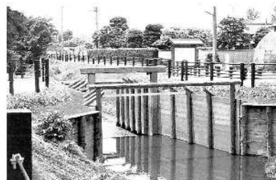
復元された通船堀東縁閘門(一の閘)
