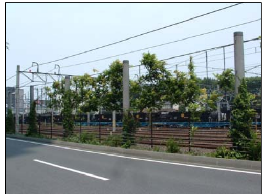
高崎線沿線(中央区)
