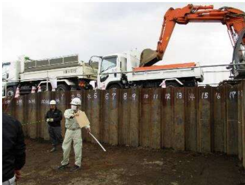
図表 2-10 土壌汚措置工事の様子
